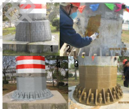
图6: 复层包覆施工流程及整体效果
